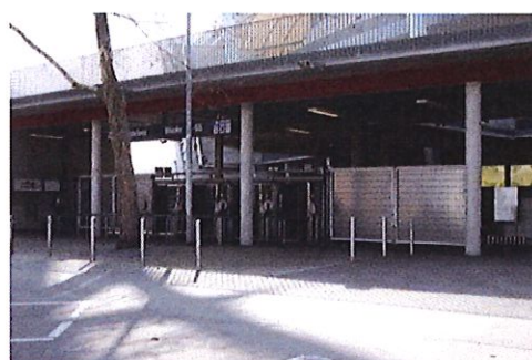
Drehkreuzanlage Gästeeingang außen. Rechts hinter dem Metalltor befindet sich die Schleuse für die Durchsuchung der Fan-Utensilien
